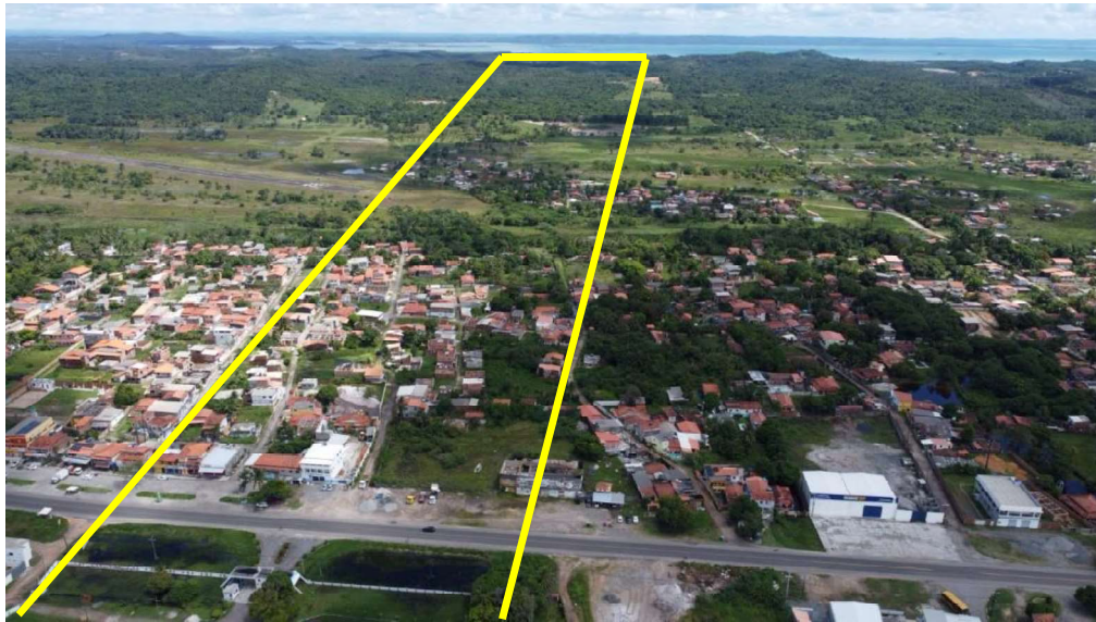
F01: registro de drone da área aproximada da Fazenda Conceição.
