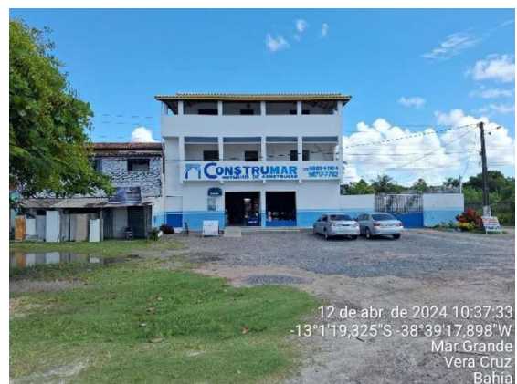
F22: edificação comercial na margem da BA 001.
