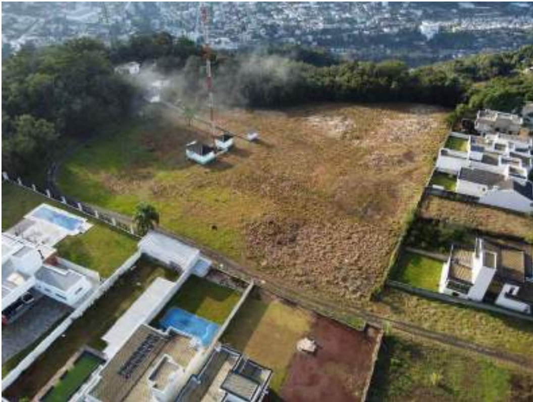
Fotografia 04 – Aspecto geral do imóvel avaliado.
