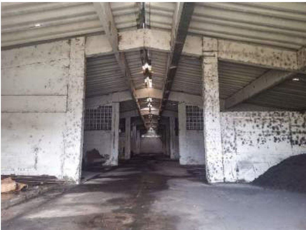
Fotografia 04 – Aspecto das construções do imóvel avaliado.
