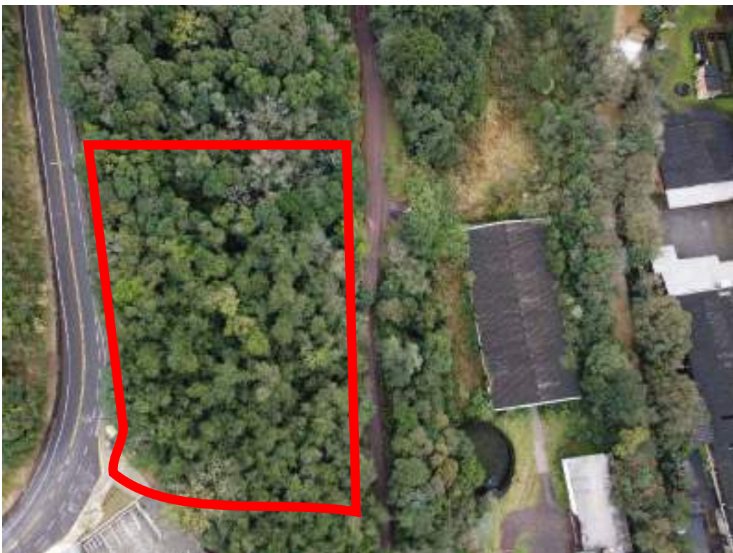
Fotografia 03 – Aspecto do imóvel avaliado e seus limites aproximados.
