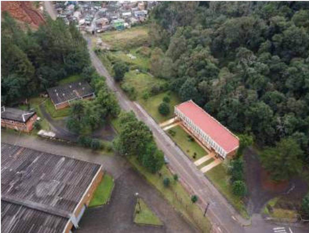
Fotografia 08 – Aspecto do imóvel avaliado e seu entorno.
