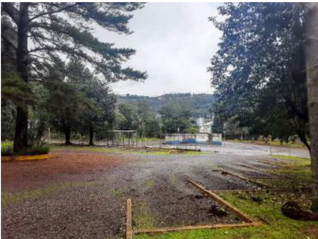
Fotografia 07 – Aspecto da área externa do imóvel avaliado.
