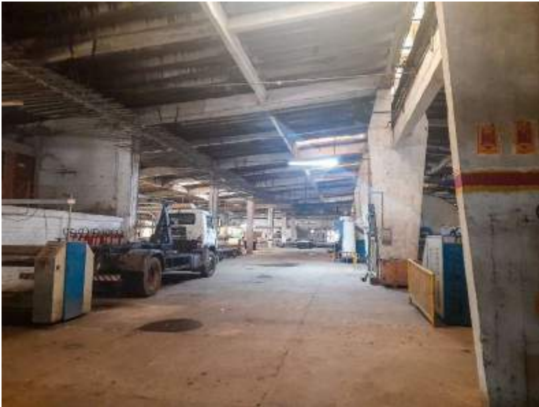
Fotografia 08 – Aspecto interno das construções do imóvel avaliado.
