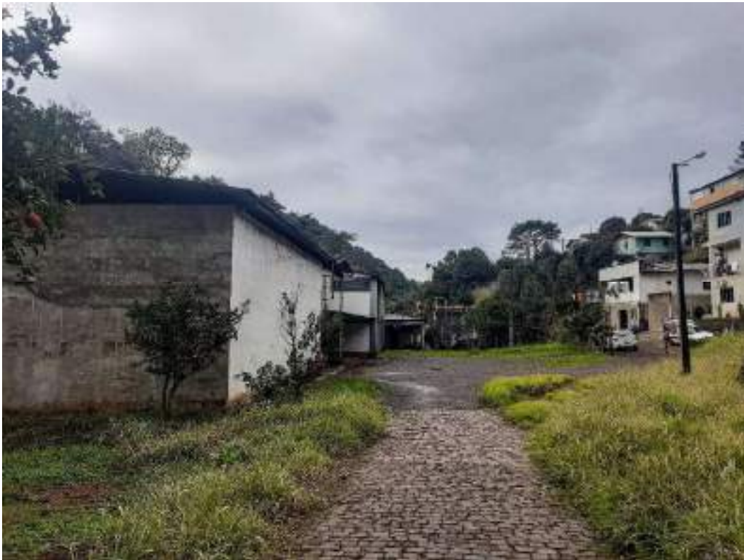
Fotografia 04 – Aspecto geral do imóvel avaliado.
