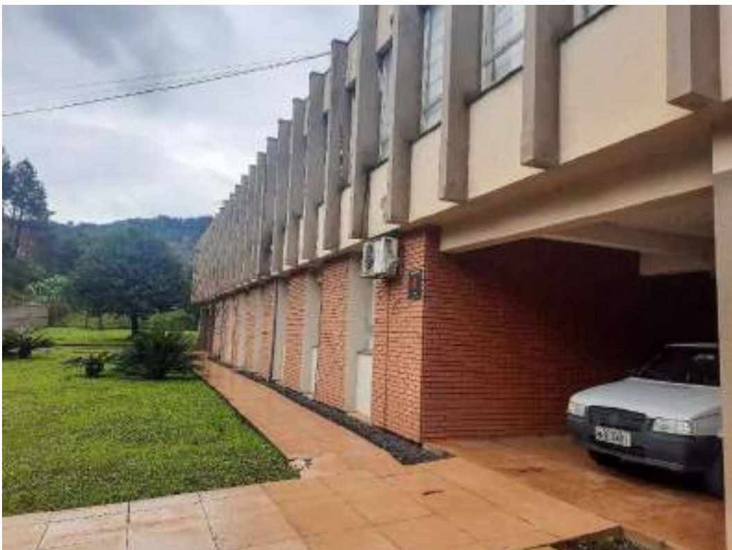
Fotografia 05 – Aspecto externo da construção existente no imóvel avaliado.
