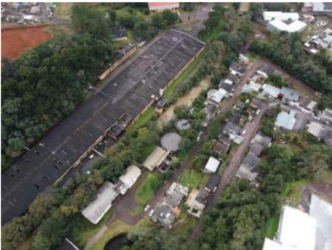
Fotografia 05 – Aspecto do imóvel avaliado e seu entorno.
