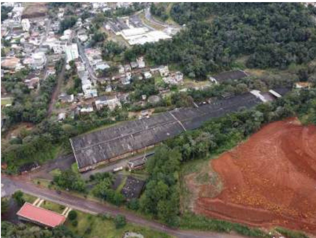
Fotografia 03 – Aspecto do imóvel avaliado e seu entorno.
