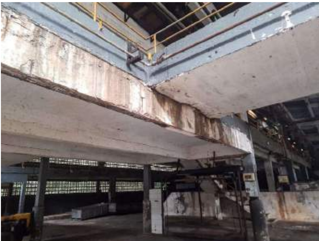
Fotografia 07 – Aspecto interno das construções do imóvel avaliado.
