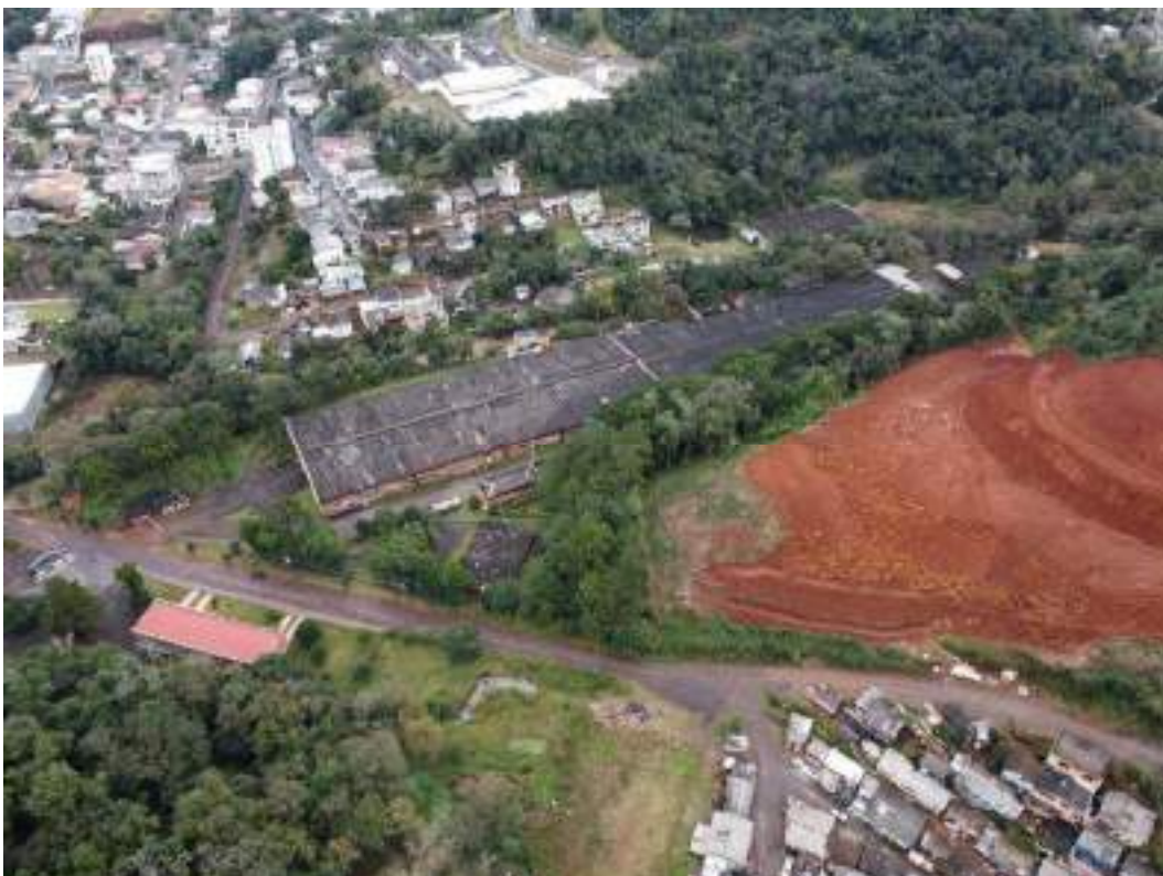
Fotografia 08 – Aspecto do imóvel avaliado e seu entorno.
