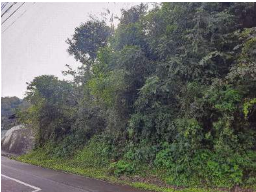
Fotografia 03 – Aspecto do imóvel avaliado junto ao alinhamento da Rua Sete de Setembro.
