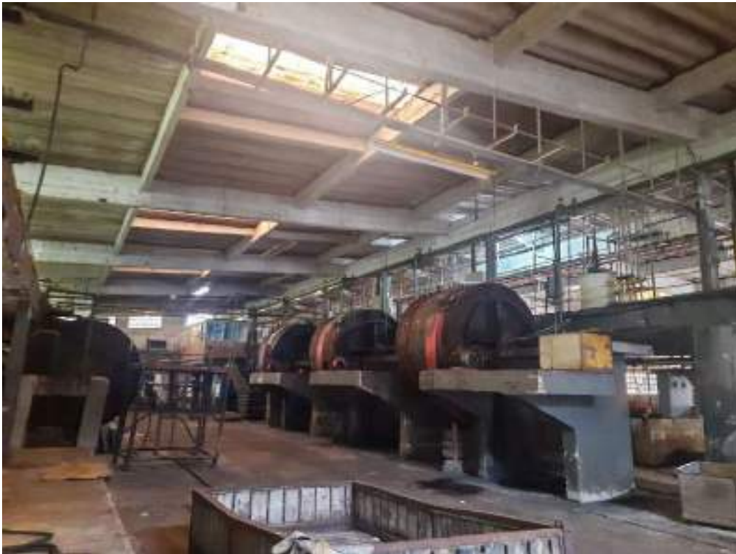
Fotografia 06 – Aspecto interno das construções do imóvel avaliado.
