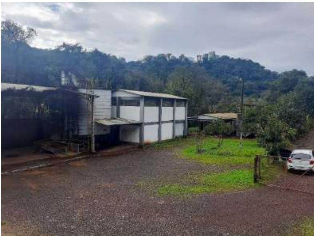
Fotografia 03 – Aspecto do imóvel avaliado e seus limites junto ao alinhamento da Rua Botânico Vivas Fernandes.
