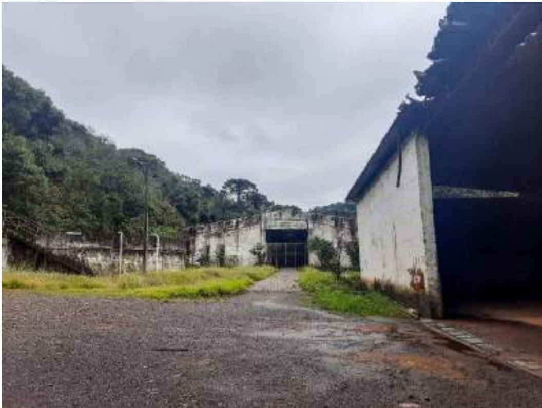
Fotografia 04 – Aspecto das construções do imóvel avaliado.
