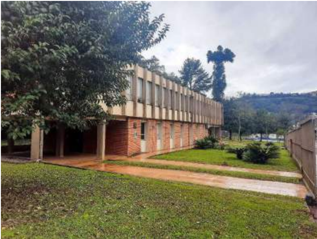
Fotografia 04 – Aspecto externo da construção existente no imóvel avaliado.
