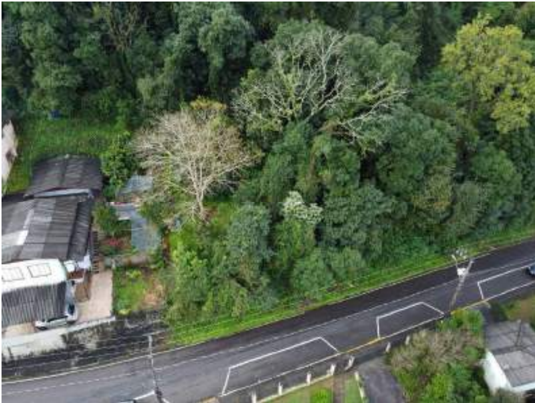
Fotografia 04 – Aspecto geral do imóvel avaliado.
