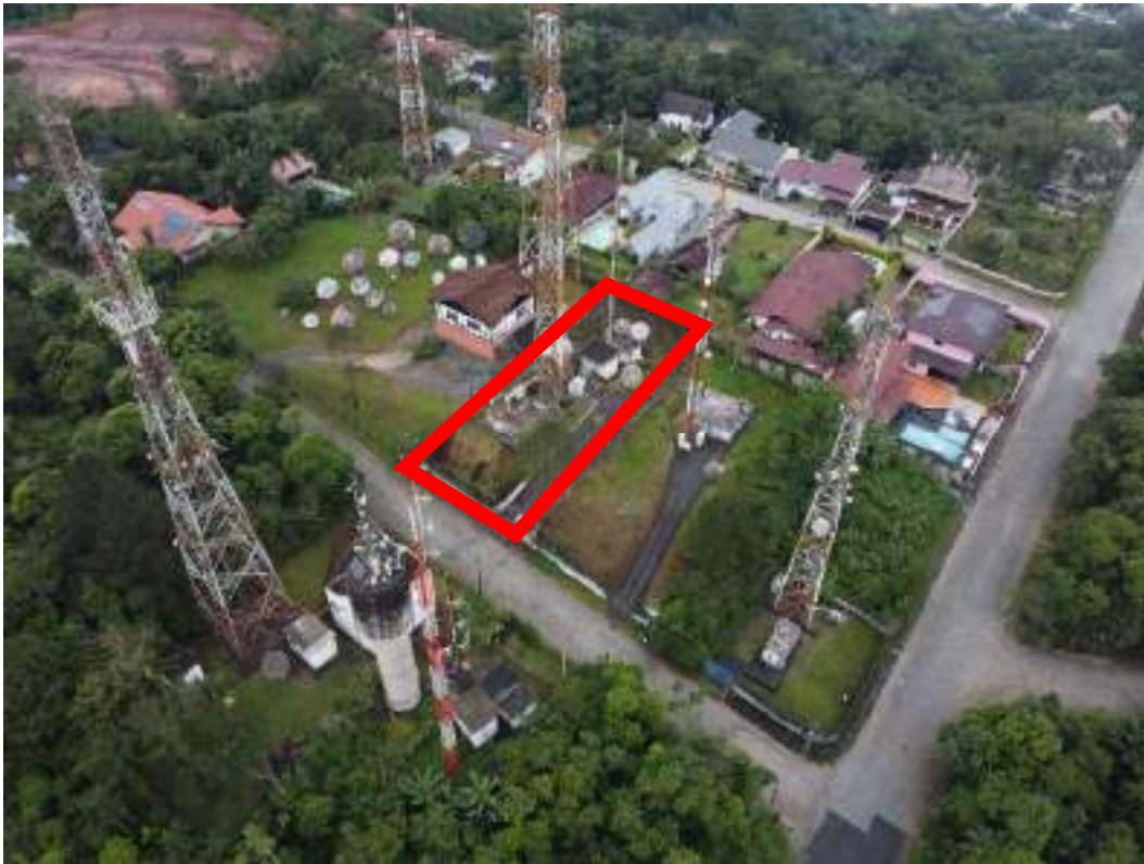
Fotografia 04 – Aspecto geral do imóvel avaliado (em vermelho) e seu entorno.
